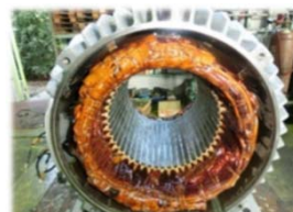
焼けてしまった 電動機の交換
