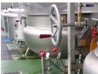
現場タンクの 補修を行います！
