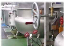
現場のタンクの 補修
