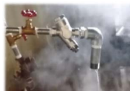
蒸気の漏れ対策など 蒸気配管メンテナンス
