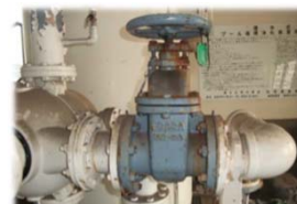
バルブ、減圧弁、 などの交換
