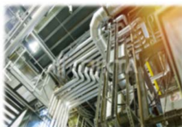
薬液などの特殊配管 の修繕メンテナンス
