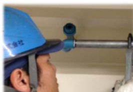
エア漏れ補修など エア配管メンテナンス
