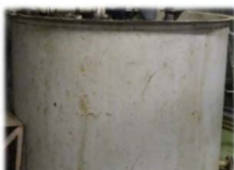
現場のタンクの 腐食対策コーティング
