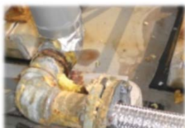
給排水管の 腐食や詰まりの解消
